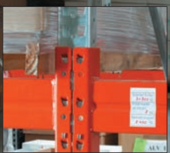
Detajl spoja stebra z prečnim delom.
