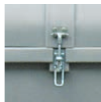
Detajl zapiranja pokrova.
